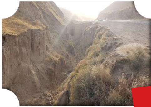
Érosion et sédimentation (couts et dégâts)
