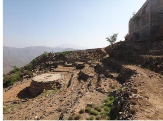
الشكل 8 و 9 سقاية (صهريج) تملأ من المياه المحصودة من الطرق ، والجدار الحجر يستخدم لتحويل أول تدفق في منطقة الواسطة
